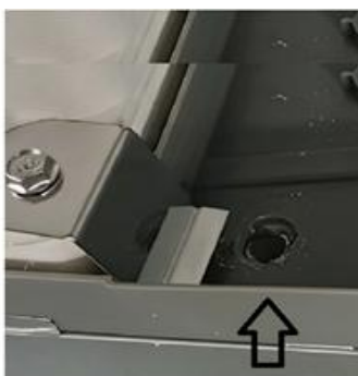
Image: Accès à la conduite de drainage interne
